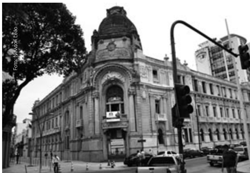
◀ Noch keine Gedenkstätte Das Ex-DOPS-Gebäude in Rio de Janeiro
